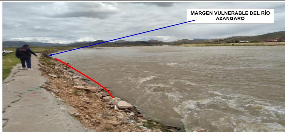
FIGURA N°01: FIGURA N°01: TRAMO CRÍTICO EN EL RÍO AZANGARO ZONAS VULNERABLES A LA SOCAVACION DE LA RIBERA DEL RIO EN LA MARGEN IZQUIERDA, EN EL SECTOR CHAUPISAWACASI, DISTRITO DE AZANGARO, PROVINCIA DE AZANGARO - PUNO.
